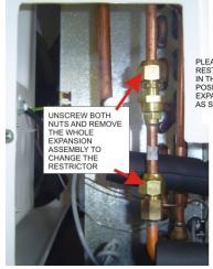
PLEASE ENSURE RESTRICTOR IS IN THE CORRECT POSITION WITHIN THE EXPANSION DEVICE AS SHOWN
